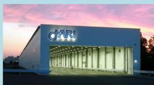
日本自動車研究所内に2017年に完成した自動走行システムの試験設備です。200mの棟内で雨、霧、日射を再現することができます。
